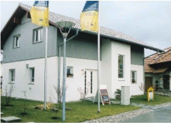
Musterhaus-Eigenheim-Siedlung im Bauzentrum Poing. Hier das OptiNorm® Niedrigst-Energiehaus mit Erdwärmehheizung. 140 m 2 Kollektorfläche sind unter der Rasenfläche in 1,20 m Tiefe „vergraben“
