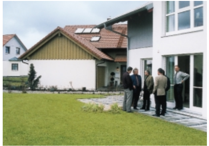
Musterhaus-Eigenheim-Siedlung im Bauzentrum Poing. Hier das OptiNorm® Niedrigst-Energiehaus mit Erdwärmehheizung. 140 m 2 Kollektorfläche sind unter der Rasenfläche in 1,20 m Tiefe „vergraben“
