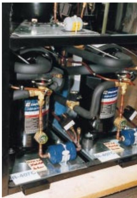
Kälteanlagenbauermeister Herbert Piergalski (Manching) erläutert hier die besondere Technologie der Direktexpansions/Direktkondensationswärmepumpe: 3 Verdichtermodule, 3 voneinander getrennte Verdampfungs- und Kondensationskreisläufe. Eingespritzt wird das Kältemittel R 407C mechanisch-thermisch
